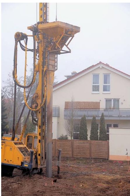
Abb.3: Herstellung von Schotter-Rüttelsäulen im Baugrund.
